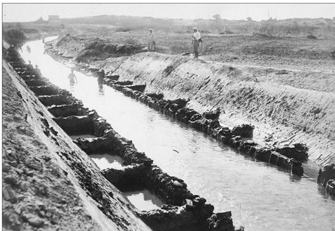
איור 5: דוגמה לעבודות ניקוז הנדסיות ויישור נחלים שבוצע בביצות הכבארה בשנות ה-20 של המאה שעברה. עבודות מסוג זה שנעשו גם לאחר קום המדינה משפיעות עד היום על המצב האקוהידרולוגי של נחל תנינים, נחל עדה ופשטי הצפה שלהם (מקור: אוסף דב קובלנוב, ארכיון התצלומים, יד יצחק בן-צבי).
